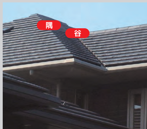
システム谷瓦(左)▲ ▲システム谷瓦(右)
